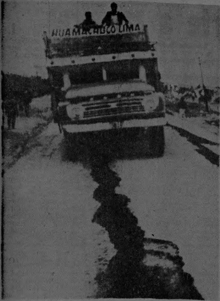
NUEVA YORK, 3 (AP). — Este camión marcha cautelosamente a lo largo de la carretera agrietada por la violencia del terremoto que azotó la parte norte del Perú. La escena fue tomada en las afueras de la ciudad de Chimote. (AP wirephoto).
